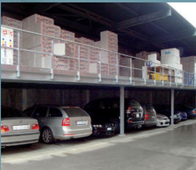
Feuerverzinkte Stahlbauhöhe für den Außenbereich. Nutzung der unteren Etage als Parkplätze.
