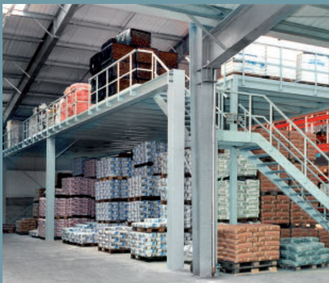
Lager-Bühne im Baustoffhandel. Lagerfläche bis unter das Hallendach. Platzierung der Treppe außen, mit Podest und Geländer in Stahl/Stahl-Ausführung.
