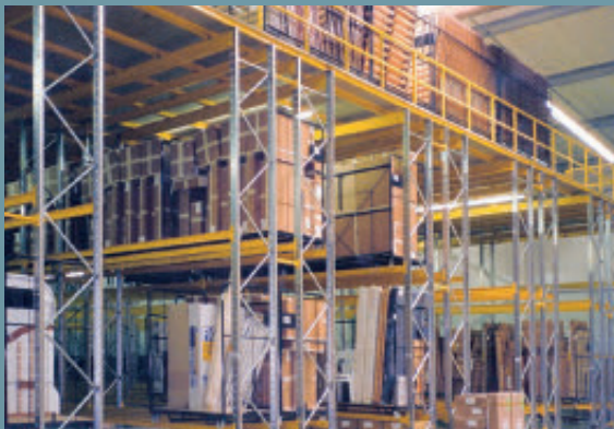
Palettenregal-Lagerbühne: Ausführung als Doppelstock-Bühne, mit Übergabestation und integrierter Sprinkleranlage.
