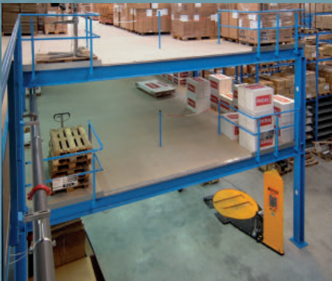
Mehrstöckige Lagerbühne bei einem Fachgroßhandel. Lagerung von mehr als 5000 Artikel, Konfektionieren und Kommissionieren auf geringer Grundfläche.
