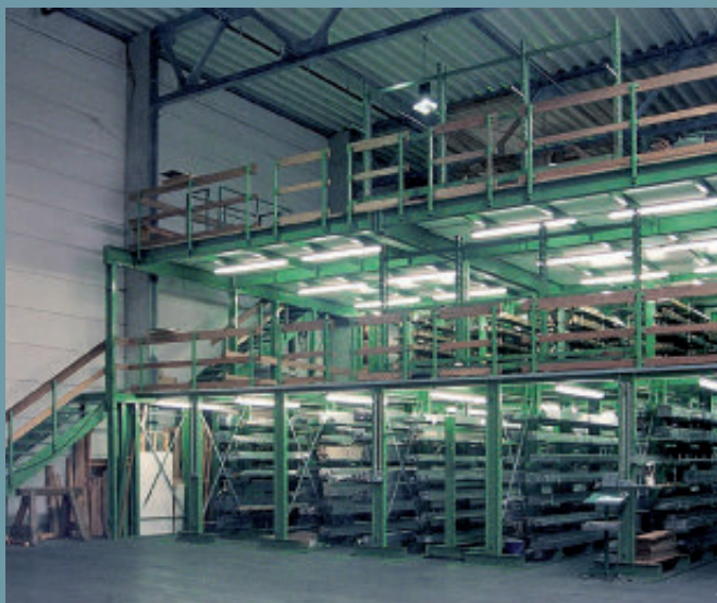
Kragarmregal-Lagerbühne im Metall-Lager. Auf 2 Etagen Lagerung von Profilen in Kragarmregalen. Oberste Ebene für Paketware und Blocklagerung.
