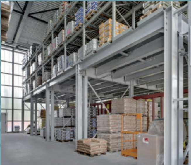
Robuste Stahlbau-Lagerbühne im Baustofflager. Hier mit integrierter Fördertechnik durch den Einbau von Rollenbahnen.
