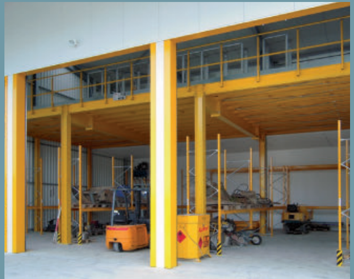
Zugeschnitten auf die vorhandene Hallenabmessungen. Lagerbühne mit Regalierung unterhalb und auf der Lagerbühne.
