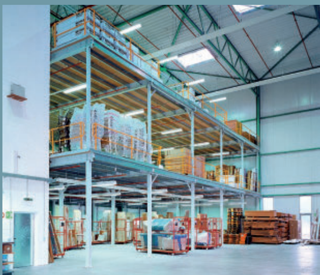
Im Möbellager. Hohe Stützen für die Lagerung von sperrigen Möbelteilen. Lagerbühne mit 3 Stockwerken, komplett mit Geländer, Übergabestation und Sprinkleranlage aus einer Hand.
