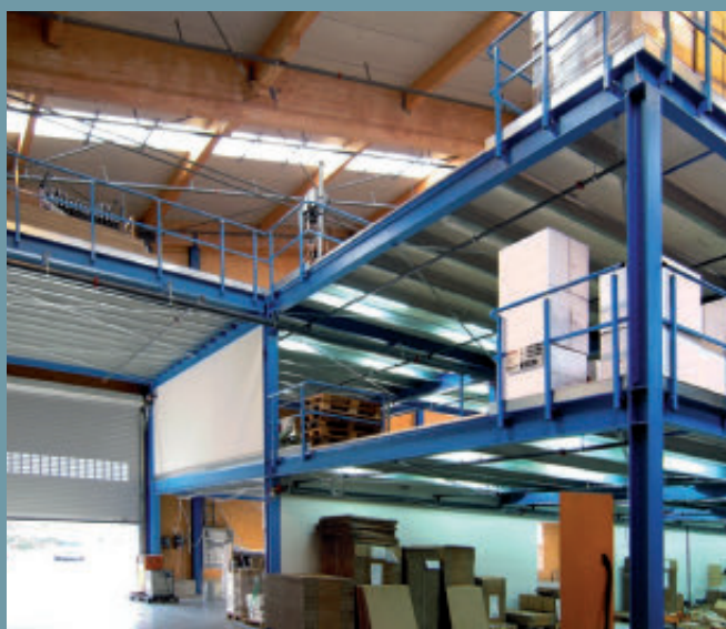
Lagerung und Kommissionierung auf 3 Ebenen. Höchstmögliche Nutzung der vorhandenen Lagerfläche inkl. einer Lagerebene über dem Hallentor.
